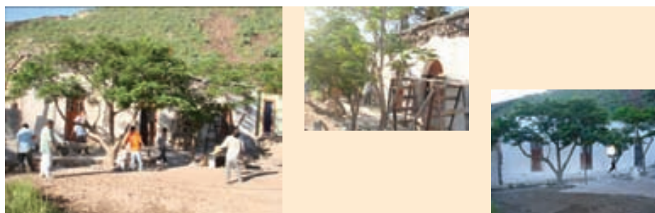
Antes, durante y después de la restauración de las fachadas del centro histórico de San Miguel de Comondú
