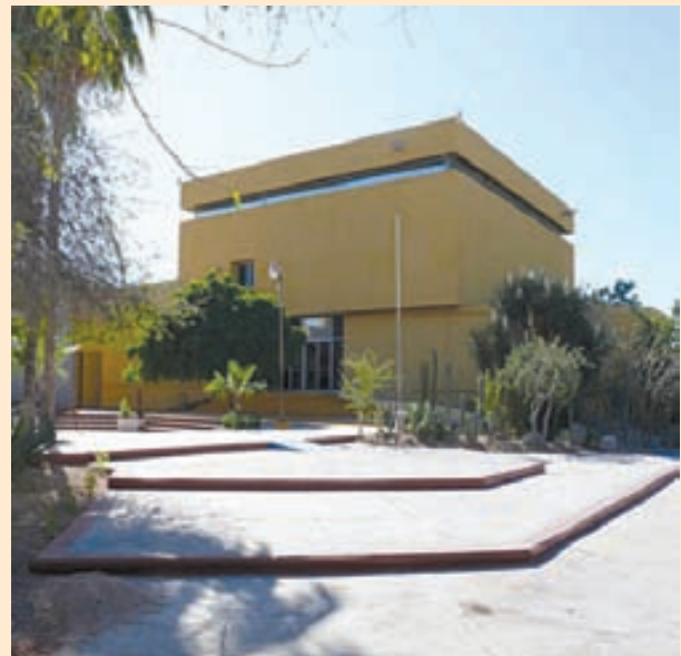
Antes, durante y después de los trabajos de reparación y mantenimiento en el museo.
