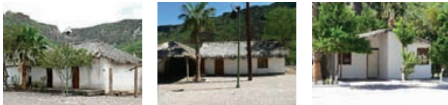
Antes, durante y después de las actividades de mantenimiento y pintura en fachadas de las viviendas del centro histórico de la localidad de San Javier.
