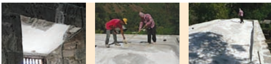
Antes, durante y después de los trabajos de conservación de la Misión de San José de Comondú.
