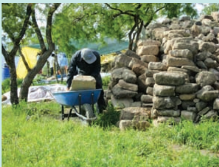
Trabajadores acarreado y acomodando piedra.
