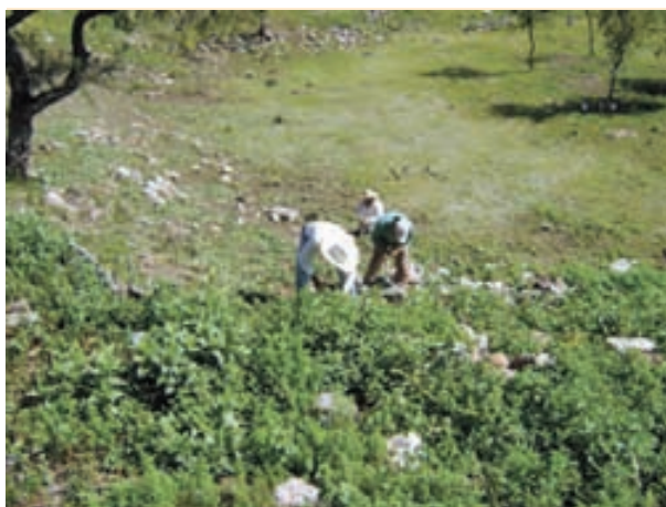
Desmonte en áreas próximas a excavar.
