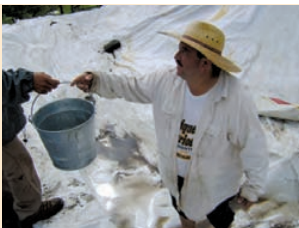
Desagüe de las excavaciones.
