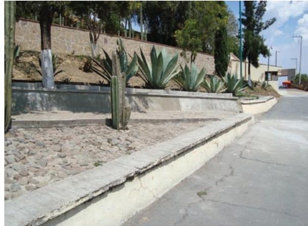
Cacaxtla: retiro de pared deteriorada, corte de raíces, contención y arreglo de plantas, levantamiento de muro y colado de remates.
