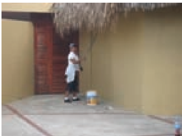
Aplicación de pintura en el exterior de la Unidad de Servicio.
