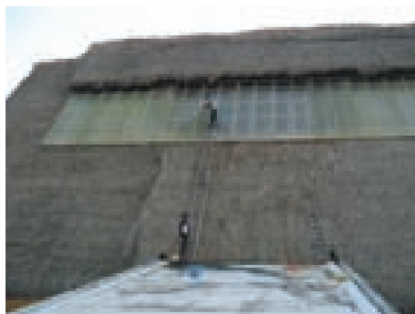
Trabajadores limpiando las láminas de policarbonato con el hidrojet.
