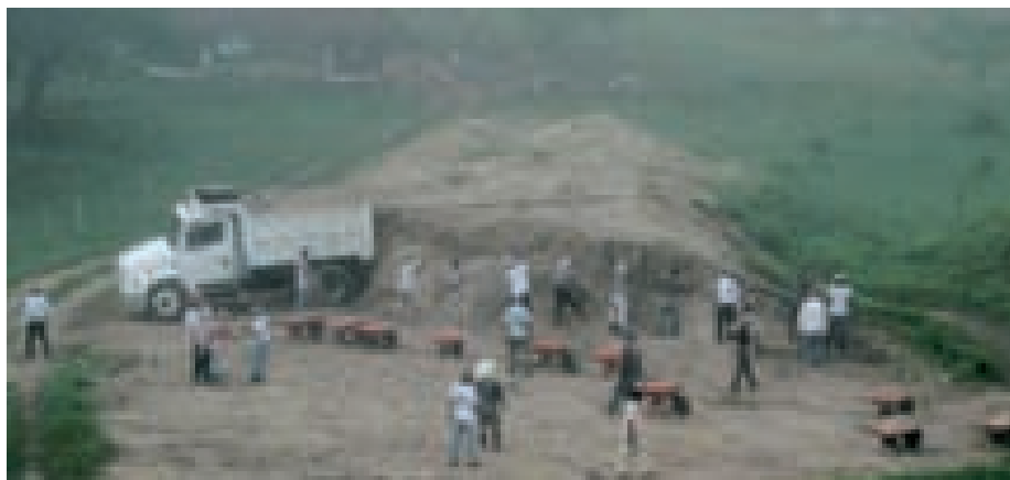
Remoción del escombro.
