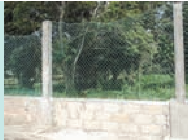
Barda perimetral reparada.
