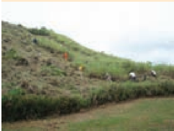
Trabajadores adscritos al PET cortando el césped del Edificio C-1 y limpiando la guardarraya tanto en el interior como en el exterior.
