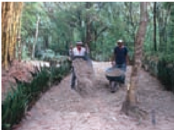
Trabajadores acarreado grava para colocarla sobre el camino principal del sendero ecológico.
