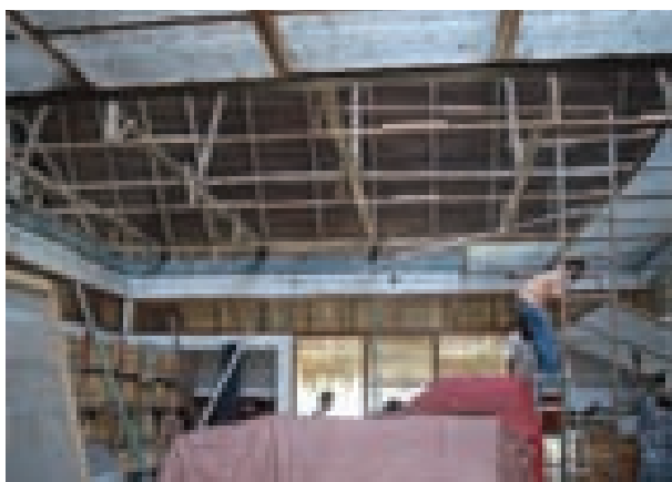
Trabajadores bajando los cielos de la bodega de bienes culturales para lavarlos.
