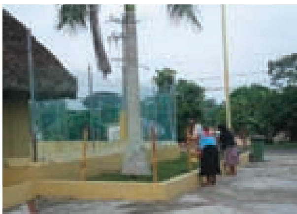
Mujeres raspando con un cepillo de alambre para retirar la pintura a las estructuras metálicas.
