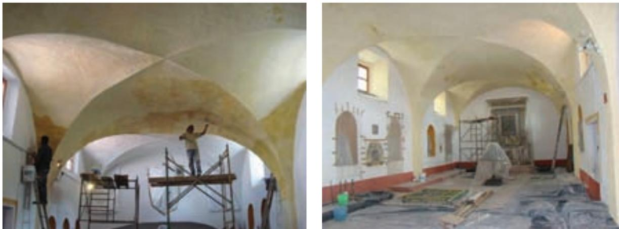
Elaboración y aplicación de pintura a la cal en muros.
