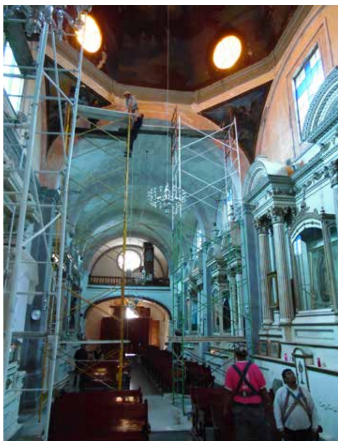
▲ Trabajos de restauración en la bóveda principal del templo. CNCPC | © INAH, 2015.
