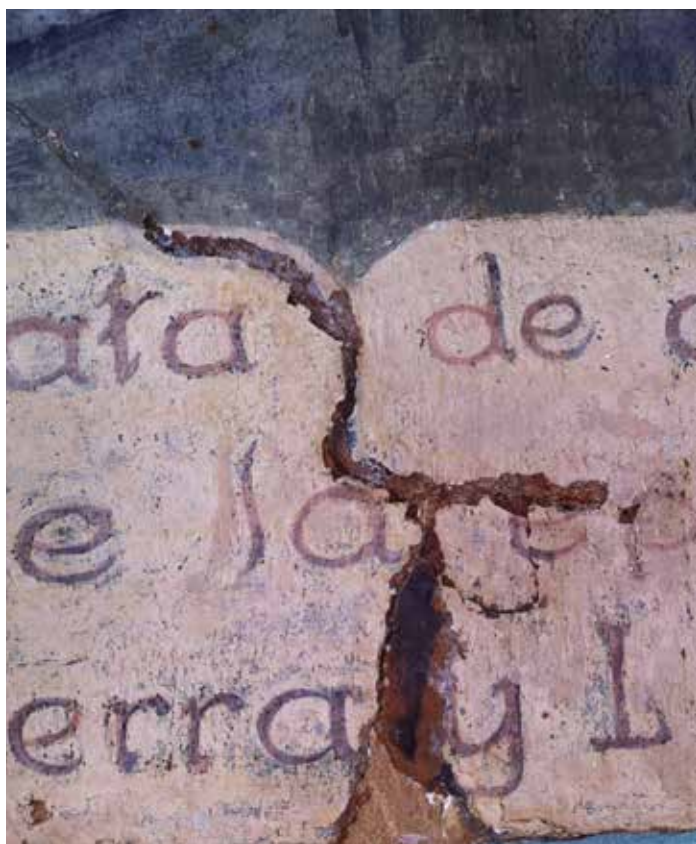
▲ Detalle de fractura del panel. CNCPC | © INAH, 2015.
