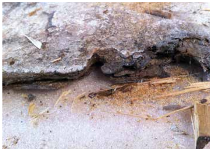
▲ Ataque de carcoma en travesaño. CNCPC | © INAH, 2015.
