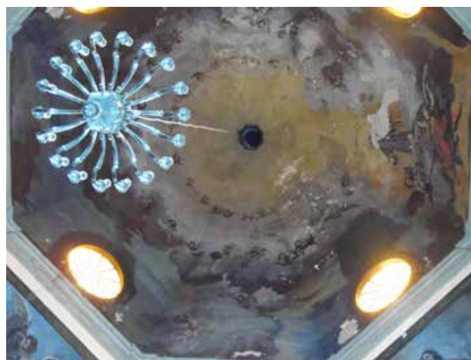
▲ Bóveda principal del templo. CNCPC | © INAH, 2015.
