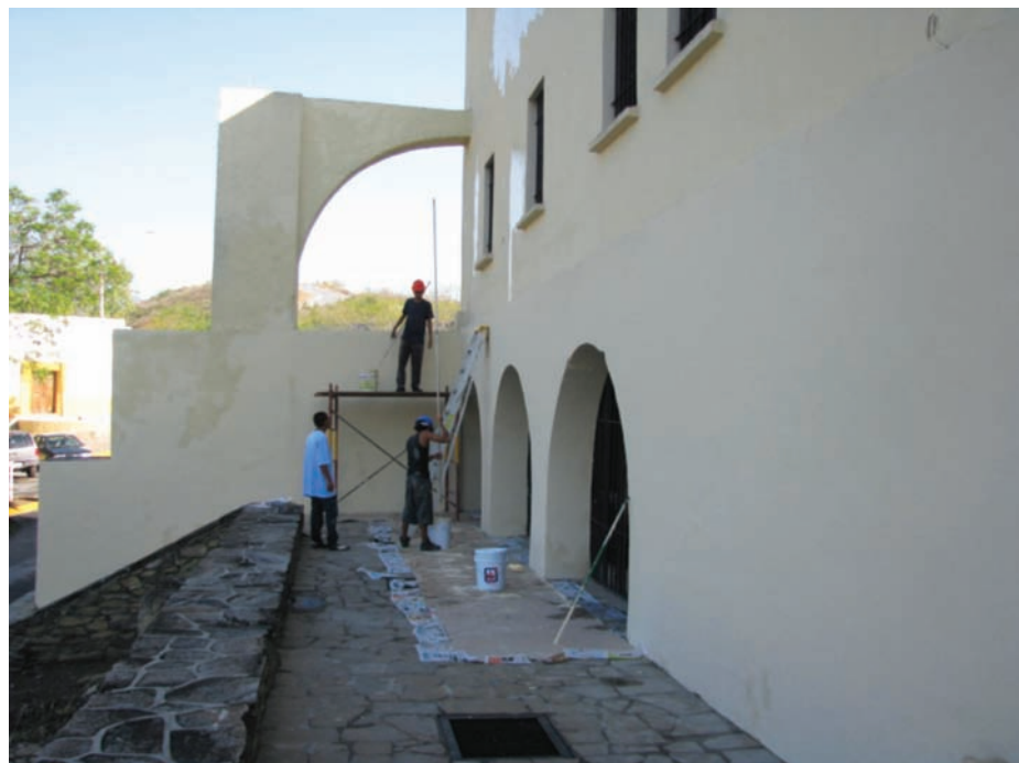
Beneficiarios del PET pintando los muros exteriores.
