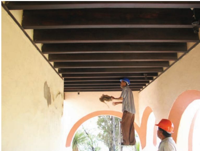
Trabajos de resane en los muros interiores del museo.
