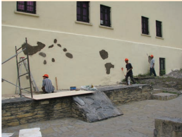
Trabajos de resane en los muros exteriores.
