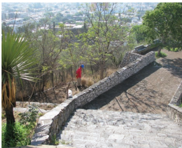
Limpieza de muros y escaleras que colindan con el cerro.
