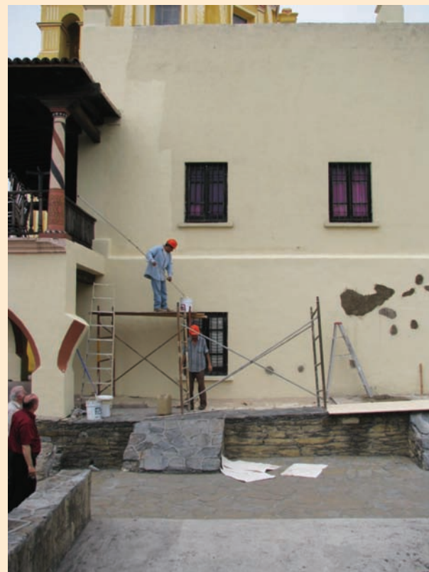
Trabajos de resane en los muros exteriores.
