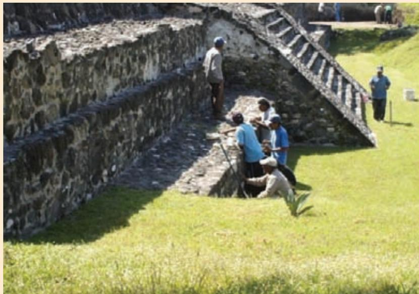
Trabajos de remoción de vegetación y sellado de los huecos donde se encontraban las raíces. A la izquierda se aprecian los trabajos en el sector norte de la fachada poniente del edificio; a la derecha los mismos trabajos en el muro sur de la plataforma adosada a la fachada poniente del edificio.
