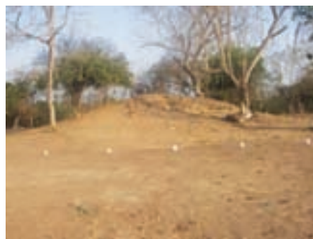
Trazos del perímetro donde se colocó la malla ciclónica.
