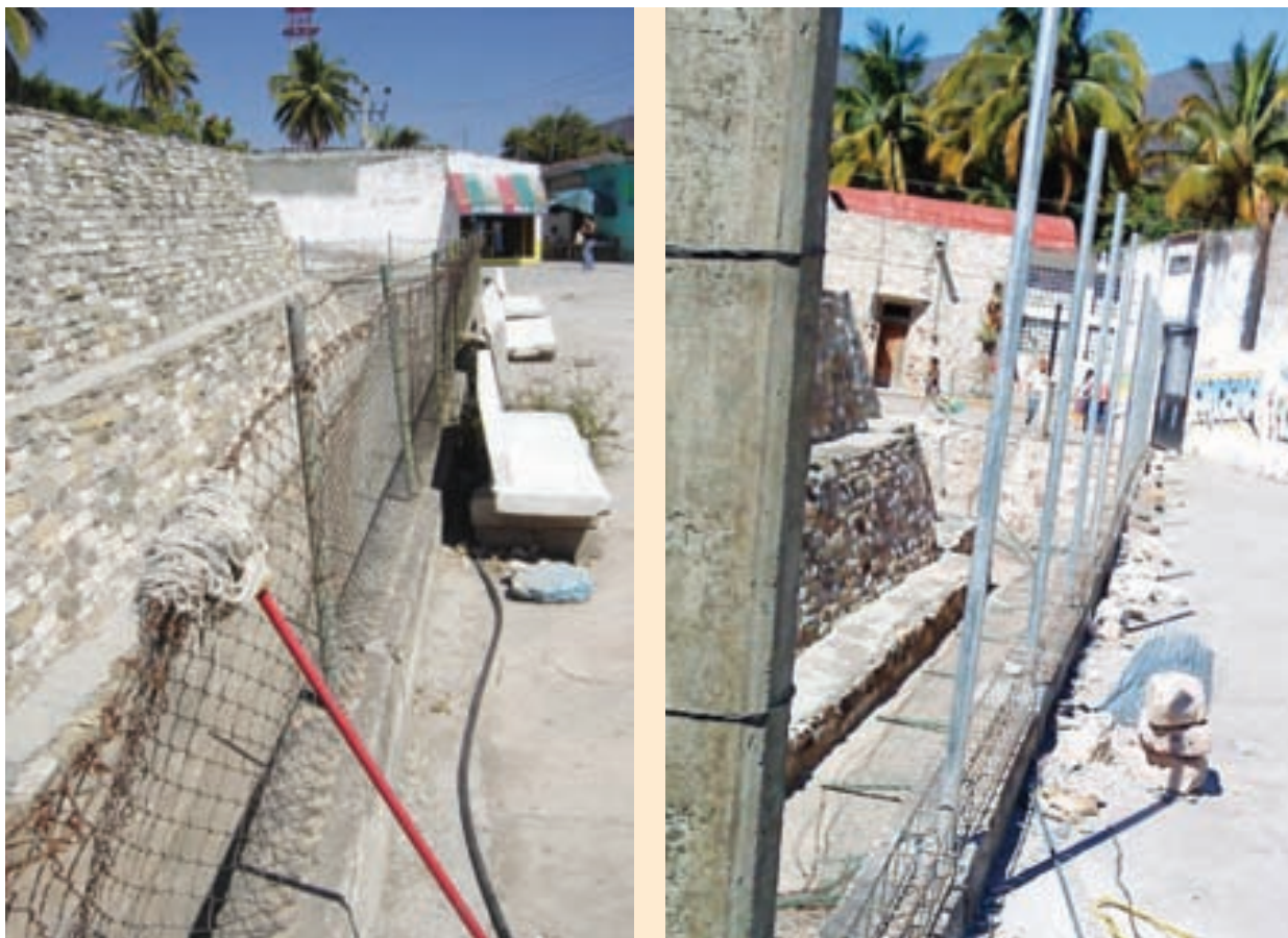
Imágenes del proceso de sustitución de la malla.
