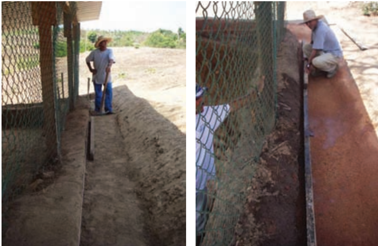
Intervención en la canaleta y proceso de colocación del modelado en barro.
