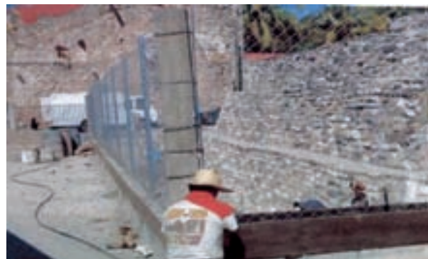
Procedimiento para la colocación de la dala de cimentación.
