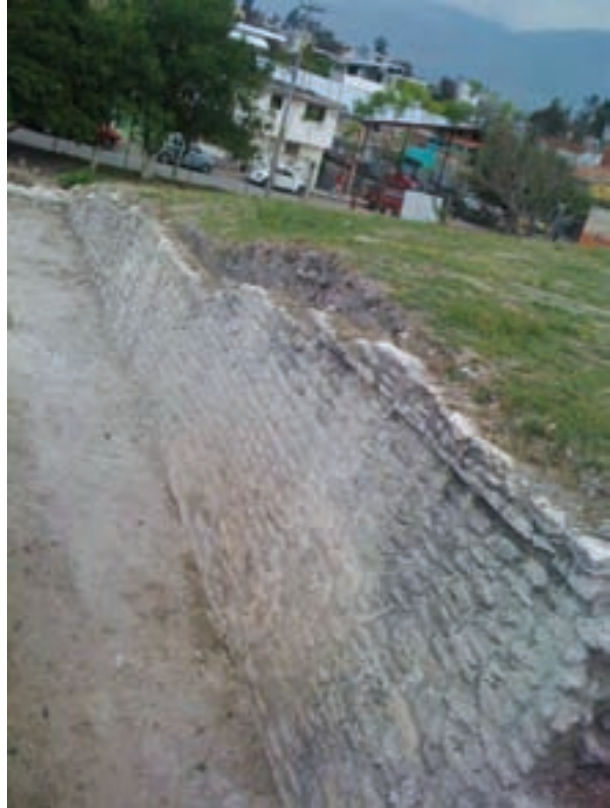
Muro del gran basamento.
