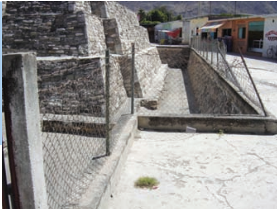
Estado de la malla antes de la restitución.
