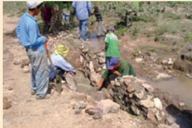
Construcción de un muro de contención para evitar que el agua dañe al camino de acceso.
